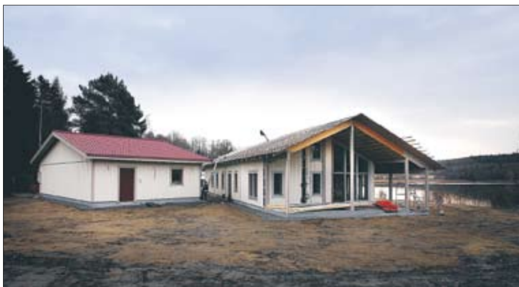
Stirra dig inte blind på vad det kostar att bygga ett hus utan titta noga på vad driftskostnaden blir, är budskapet från de som bygger kretsloppshus. Byggnormen för ett vanligt hus är att det får dra 130 kWh/m 2 . Motsvarande siffra i ett kretsloppshus ligger på 20-40 kWh/m 2 .
