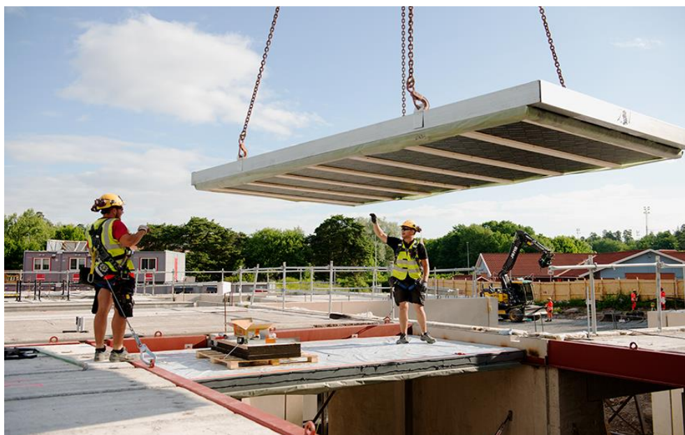
Bild 5 – Det andra KOLJERN® - elementet lyfts på plats. Elementvikten är c:a 80-100 kg/m 2
