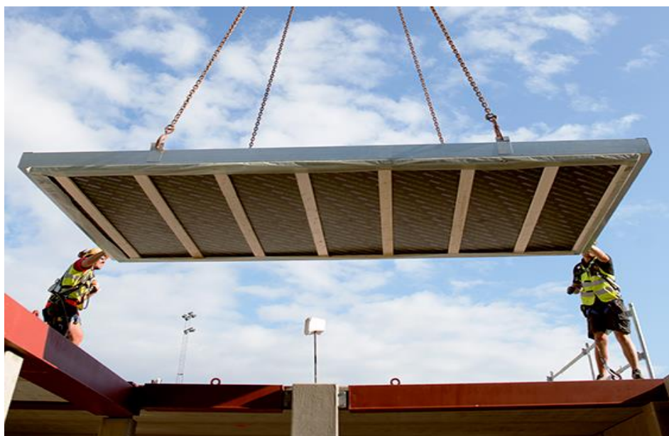
Bild 3 – Det isolerande och bärande KOLJERN® - elementet lyfts på plats. Elementets storlek är 2,4 x 4,8 m och har även underliggande gles/distanspanel monterad från fabrik.
