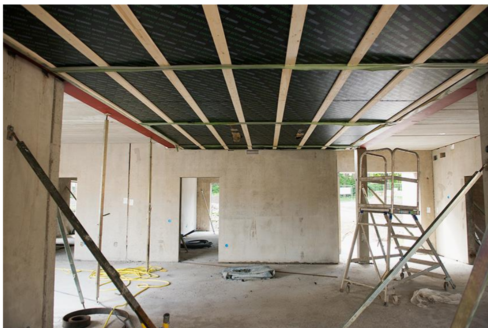
Bild 8 – Elementets undersida efter montage.
