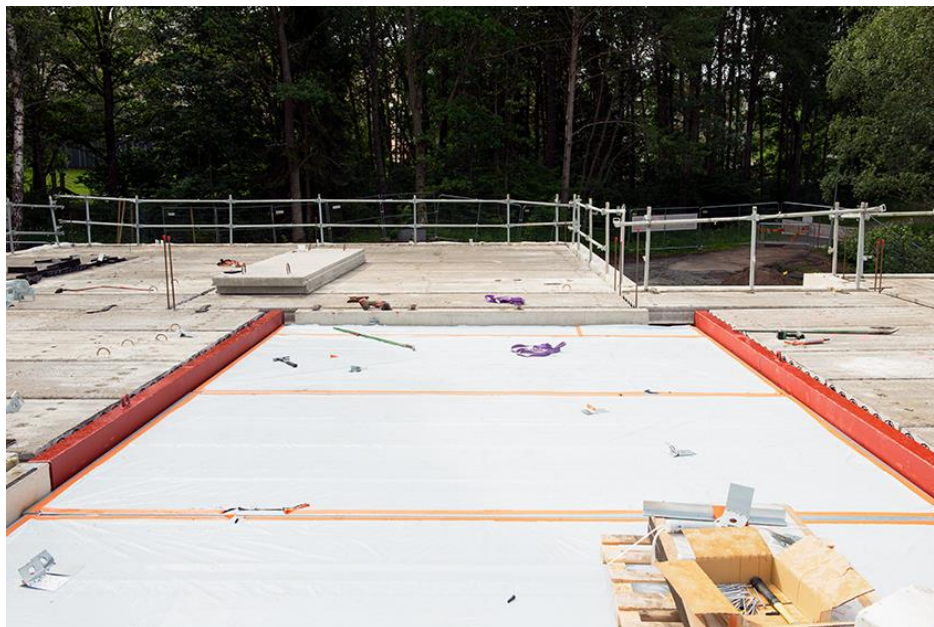
Bild 9 – Elementets ovansida levereras skyddsplastad. Detta tas sedan bort i samband med monteringen av ovanliggande takfallssisolering.
