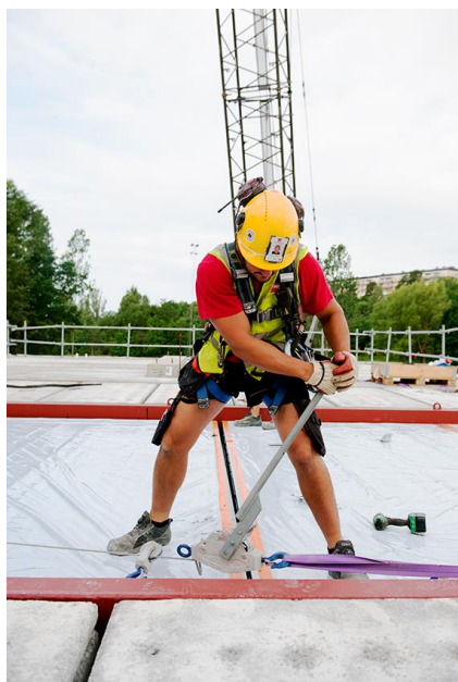
Bild 6 – När sista elementet är på plats så dras dom ihop med ett vajerblock och sedan sammanfogas med plåtvinklar och plåtbeslag.
