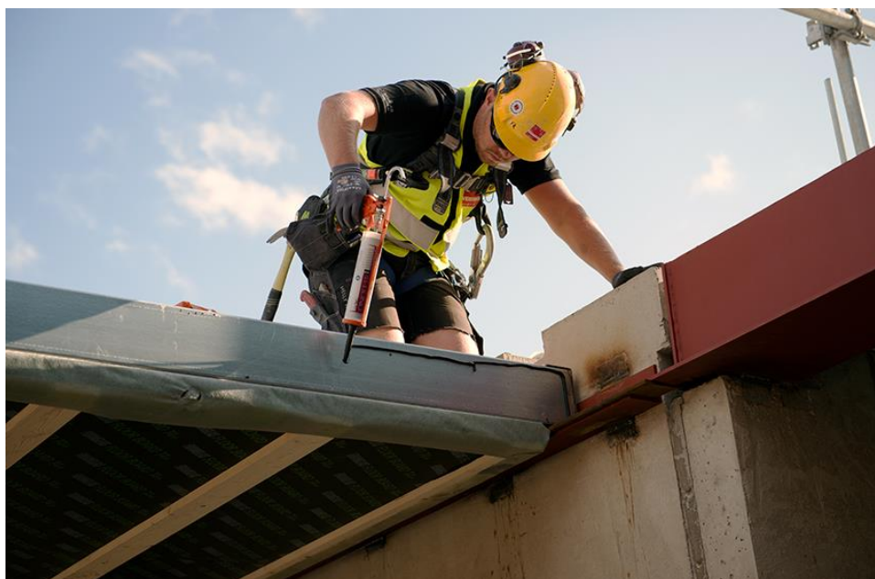
Bild 4 – KOLJERN® - elementet är på plats . För att säkra lufttäteten mot nästa element så appliceras en mjukfog. Den gröna lufttätetsväven viks ner i senare sked då innertaket monteras.
